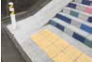
車道の縁石の段差を「新38段階」に認定
